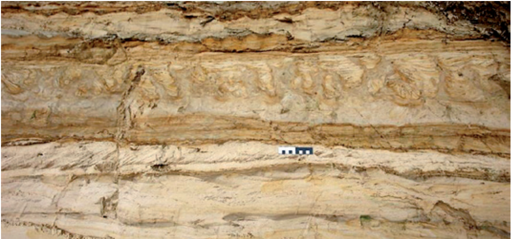
2 pav. Slinkio atodanga: injekcinės struktūros, susiformavusios apatiniame molingame sluoksnyje ir kylančios į viršuje esantį smėlio sluoksnį.
