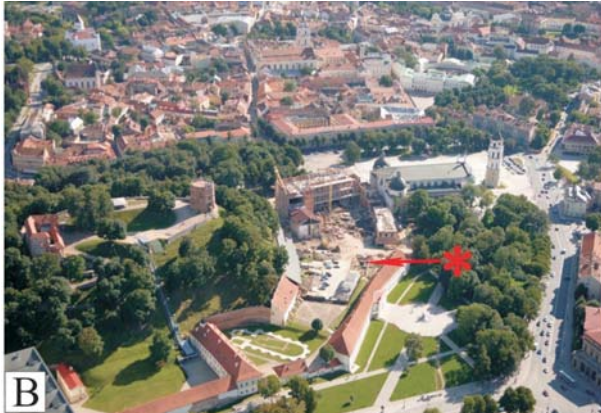
1 pav. Vilniaus Valdovų rūmų teritorijos situacinė schema (A) ir vaizdas (B) iš paukščio skrydžio (M. Jovaišos nuotrauka): 1 – aukštumos; 2 – absoliutinis aukštis, m; 3 – šlaitai; 4 – upės; 5 – tiltai; 6 – gatvės; 7 – pastatai; 8 – Žemutinės pilies komplekso teritorija; 9 – tyrimų vieta.
