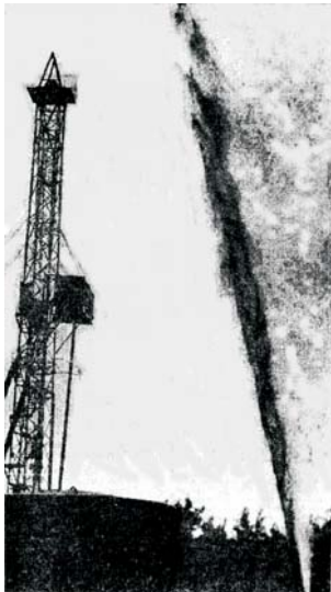
1968 m. birželio 5 d. iš Gargždų gręžinio smiltainių ištryškęs naftos fontanas (68 m 3 /para) (autorius nuotraukos).
